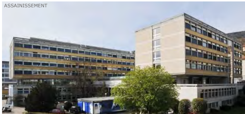
Les bâtiments vétustes du CPLN seront assainis d'ici mars 2018.
