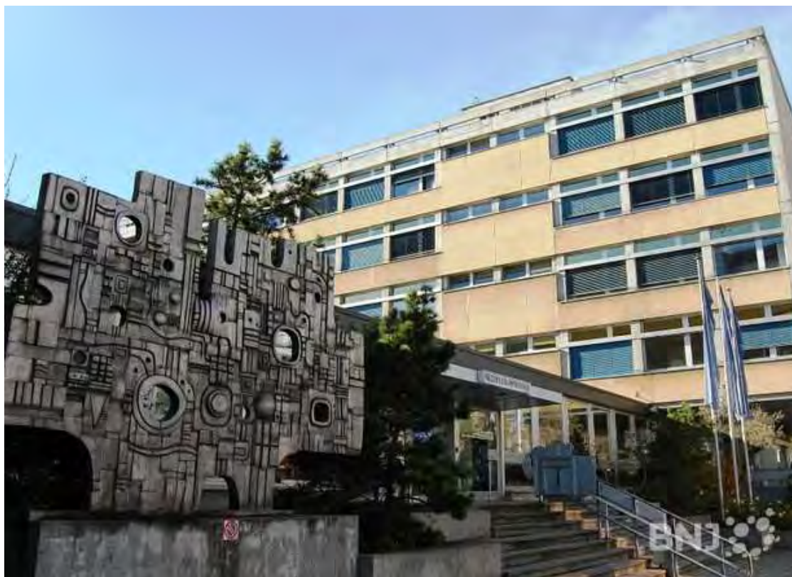
Le bâtiment B du CPLN sera assaini.
